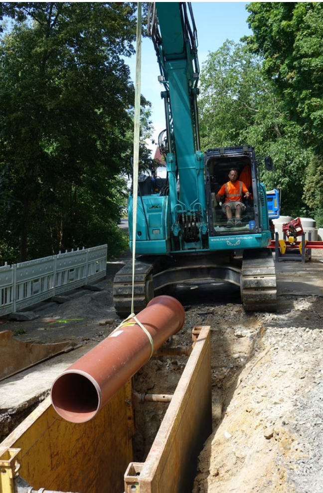
Rohre in den Nennweiten DN/OD 400 und 500 verfügen über eine angeformte Muffe und eine fest eingelegte FE®-Dichtung.
