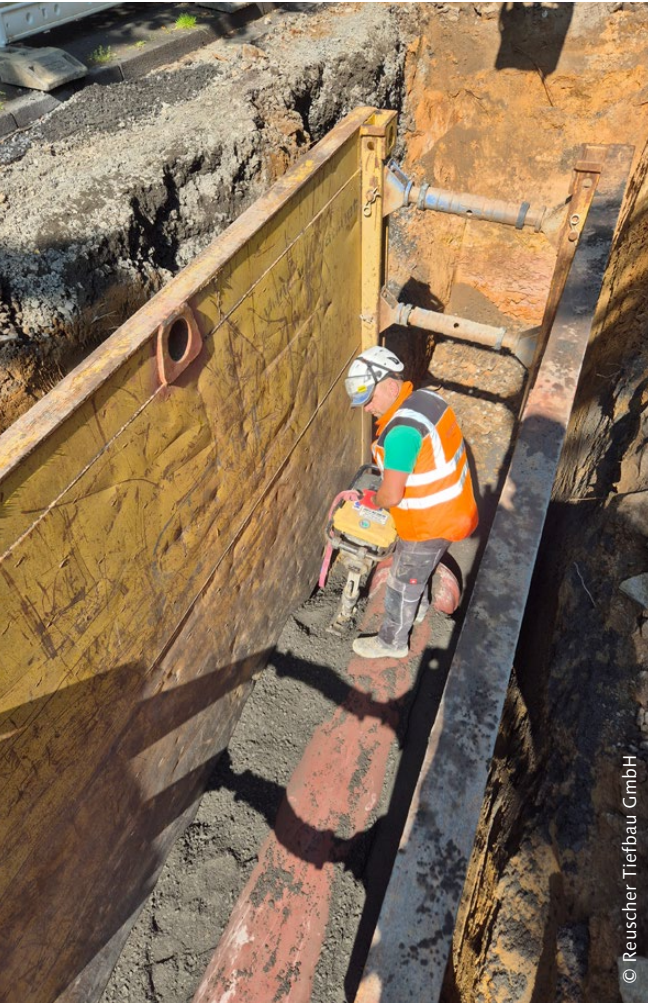
Fachgerechte Verdichtung der Rohrleitungszone
